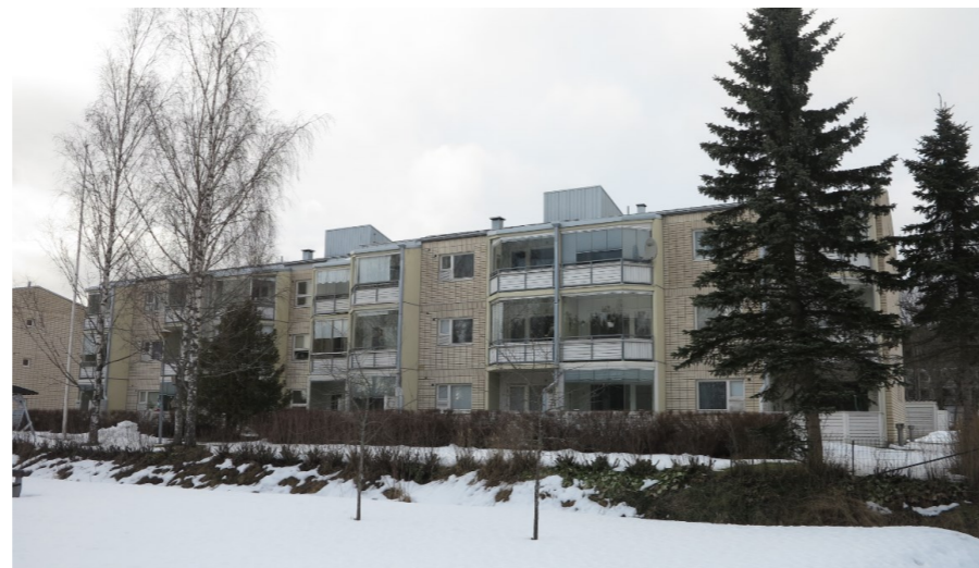
Käsiyöläisenkadun eteläreunaan 1980-luvulla rakennetut kaksi kolmikerroksista kerrostaloa poikkeavat mittakaavaltaan ja tyyppiltään alueen vanhasta rakennuskannasta..
