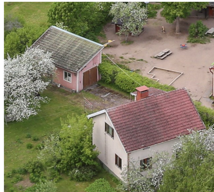
Lehtolankatu 12 on tontin reunaan kiinni rakennettu pulpettikattoinen autotalli.
