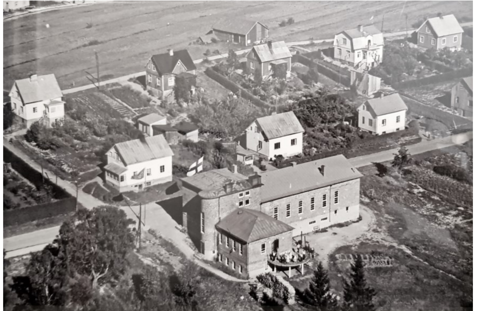
1940-luvun lopulla otetussa ilmakuvassa näkyy edustalla vuonna 1932 valmistunut työväentalo ja sen takana Vihdintien ja Suorakadun varren omakotiasutusta. Puutarhakasvein tiiviisti istutettuja tontteja rajaavat leikatut pensasaidat. Taustalla pellon reunassa on Närön lato. Kuva työväentalon seinältä.
