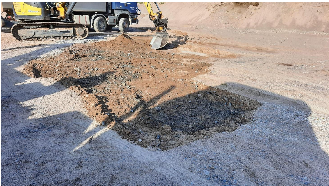
Kuva 7. Alueen itäosasta kunnostettiin noin 25 m 2 :n alue noin 0,1 – 0,2 m:n syvyyteen.
