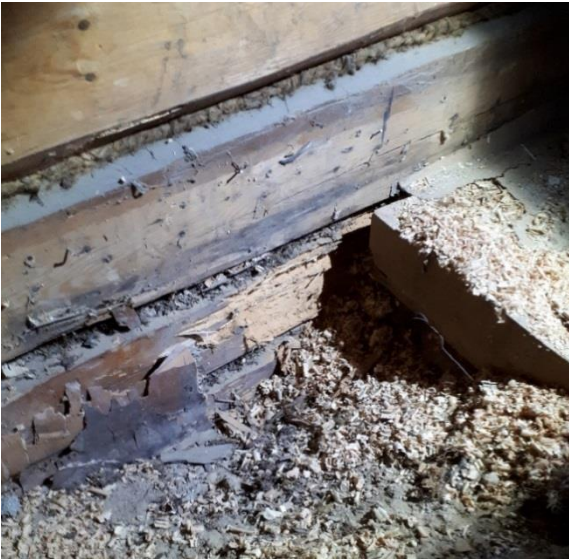
Vuoden 2017 mikrobitutkimusten ottopaikat toivat esiin tupajumin vaurioittamia hirsii.
